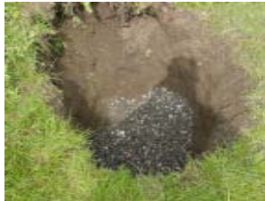
step 2. Pour stone in bottom of hole.
